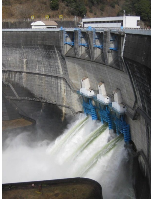
主ゲート(放流中)及びクレストゲート
