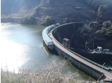
高山ダム 堤頂部
