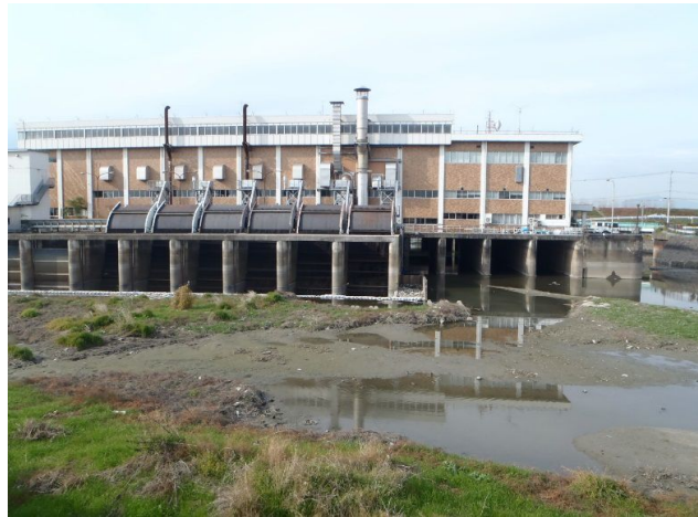
久御山排水機場 除塵設備遠望
