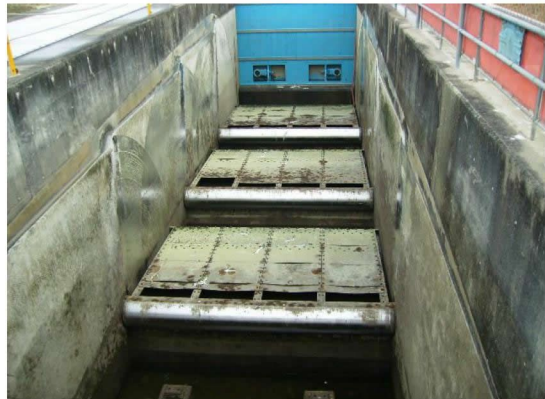
階段式魚道扉体
