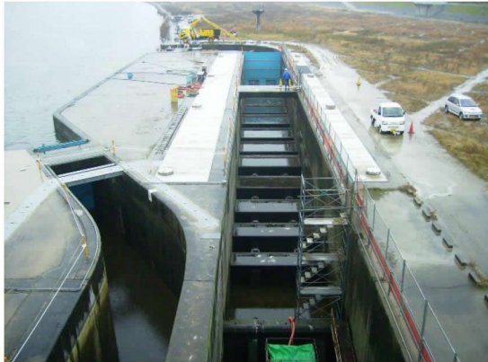
左岸階段式魚道
