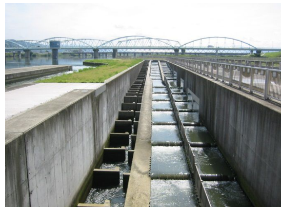
左岸階段式魚道
