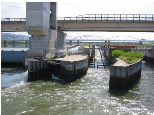
左岸複合式魚道出口
